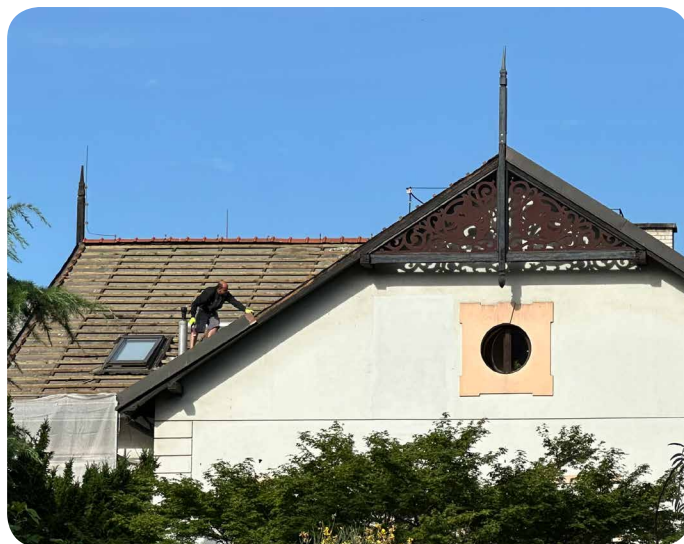
Výměna střešní krytiny na správní budově
